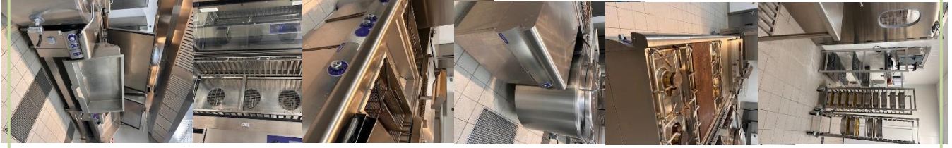
Zone de préparation
