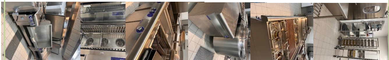
Zone de préparation
